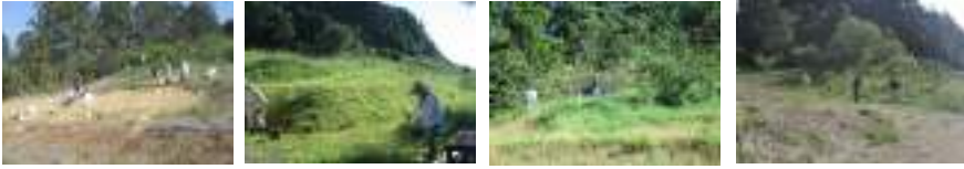
会員の御奉仕による梅園整備（法面補修、草刈り等）
